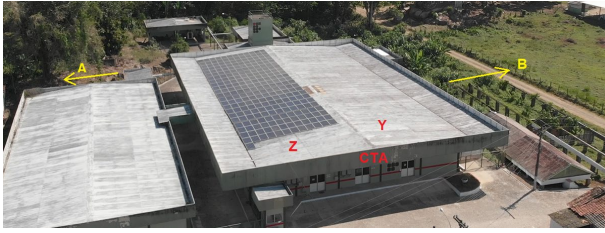
Fig. 2. Telhado do CTA
